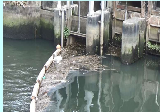
ごみを取り込む様子 (名城水処理センター)
