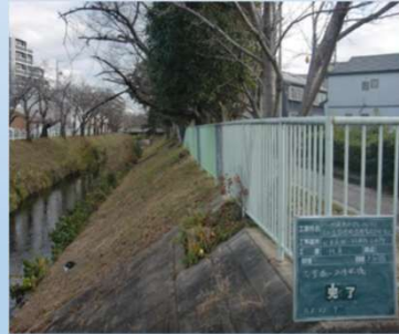
志賀橋～ 木津根橋間 (完了)
