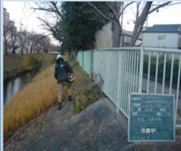
志賀橋～ 木津根橋間 (作業状況)
