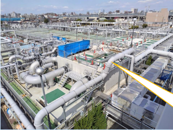
千年水処理センターの工事の様子
