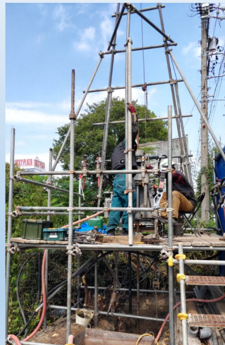
作業の様子(法螺貝橋上流左岸)
