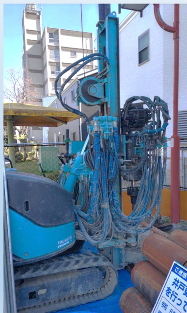
ケーシング更新作業の様子
