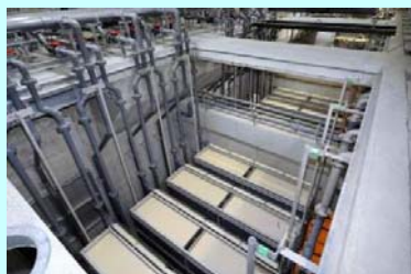
好気タンク内の 平膜ユニット (400枚 × 12ユニット)
