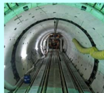
堀川左岸雨水滞水池
