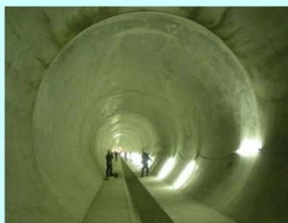
堀川右岸雨水滞水池
