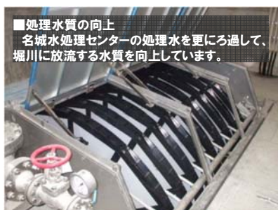
■処理水質の向上 名城水処理センターの処理水を更にろ過して、堀川に放流する水質を向上しています。
