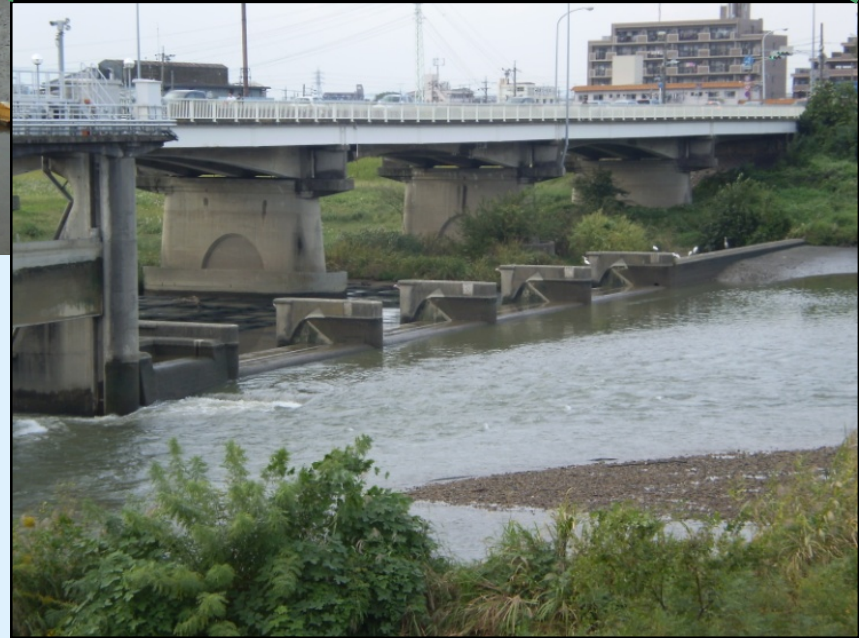
転倒ゲート×4基
