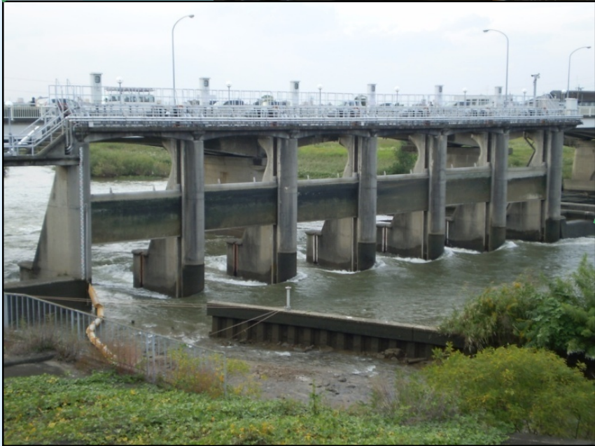
卷上げゲート×6基
