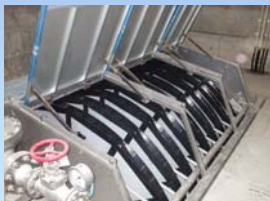
名城水処理センター・高度処理 処理方法 標準活性汚泥法+急速ろ過 供用開始 平成22年5月
