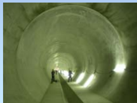
堀川右岸雨水滞水池 貯留量 13,000m 3 対象面積 633ha 供用開始 平成22年9月
