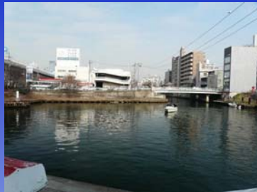
松重閘門付近
