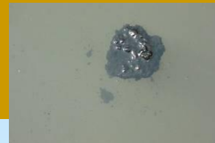
Estado de lodo flotado
